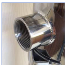
Raccords et parois: inox 6mm
